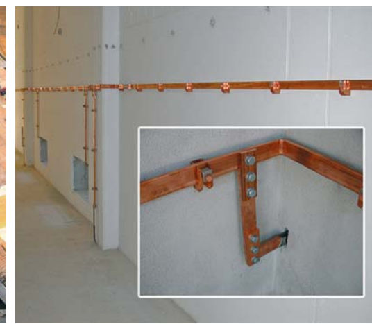
Erdung und Potentialausgleich in Kraftwerken
