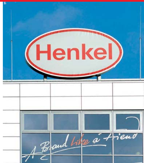
Isolierter Blitzschutz Verwaltungsgebäude
