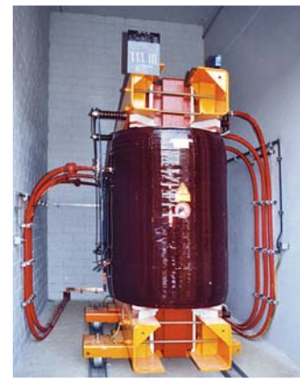
Erdungsmaßnahme an Transformatoren
