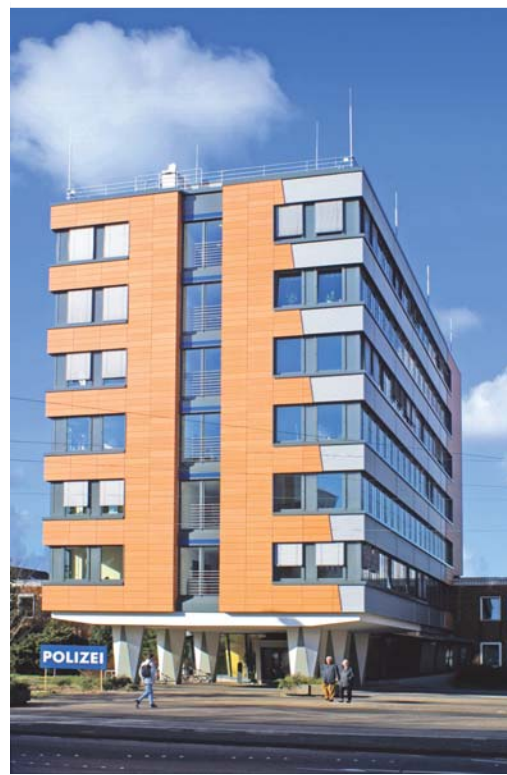
Isolierter Blitzschutz Verwaltungsgebäude
