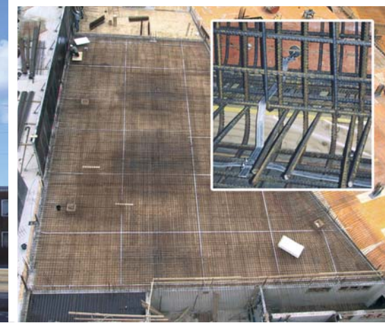
Fundamentender für ein Bankgebäude
