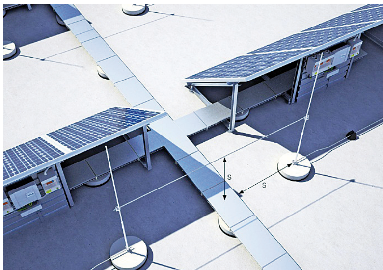
Bild 4 Anordnung von Fangstangen mit Berücksichtigung des Trennungsabstands.
