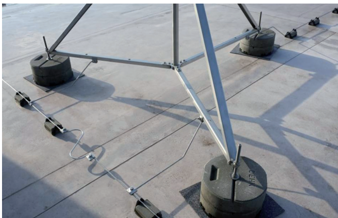
Bild 7 Fangmast mit drei Fortleitungen.
